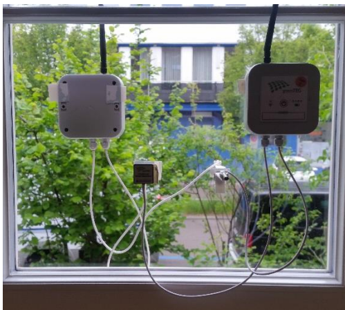
Fig. 1: Fenster mit Messknoten Typ 1 (rechts) und Messknoten Typ 2 (links). Sicht aus dem Inneren des Gebäudes.
