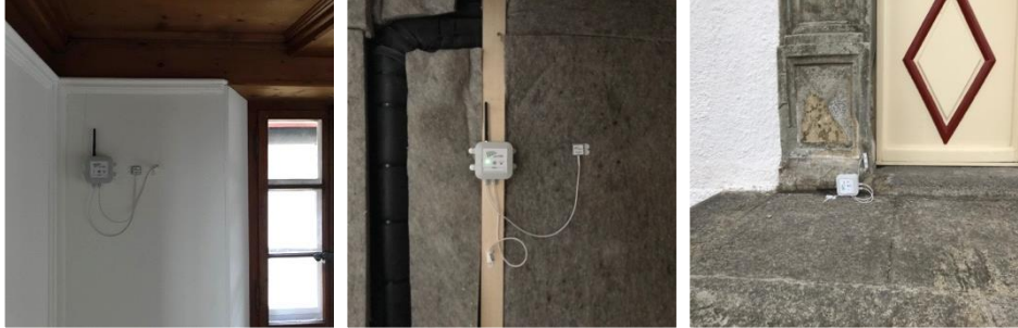
Abbildung 3-1: Messknoten vom Typ 1 an der ungedämmten Wand (links), Messknoten vom Typ 1 an der gedämmten Wand (mitte) und Messknoten vom Typ 2 aussen (rechts)
