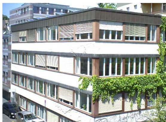
Abb. 1: Strassenfassade des untersuchten Bürogebäudes
